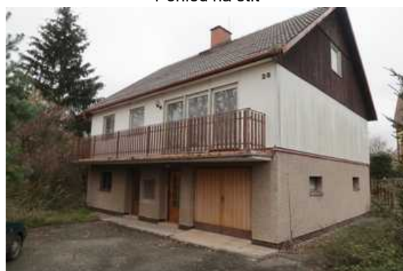
Pohled - vstup do 1 NP a balkon
